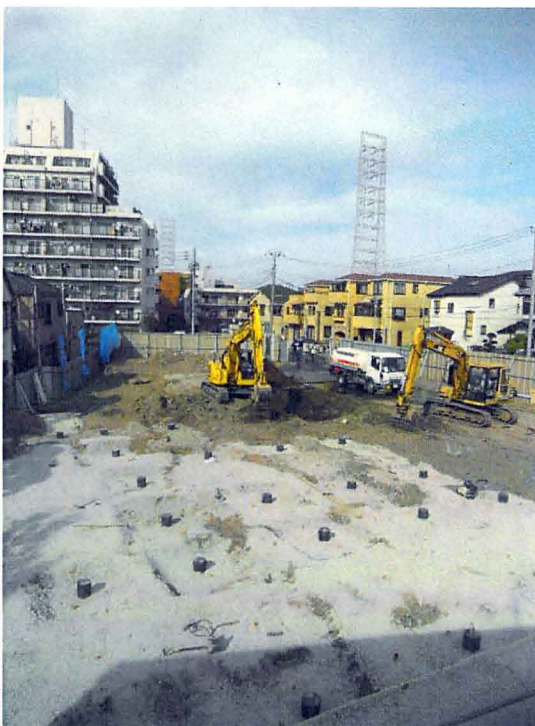
掘削の様子（左側写真）、くい打ちの様子（右側写真）
