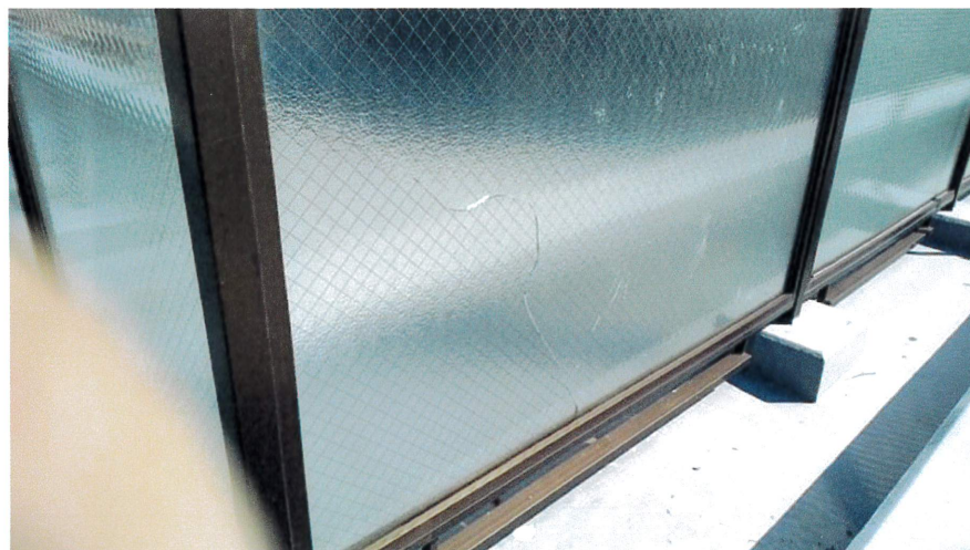
601号ベランダ手摺ガラス破損
