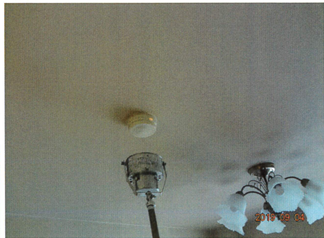
写真36(差動式スポット型感知器)
