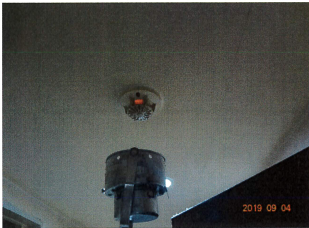
写真39(定温式スポット型感知器)
