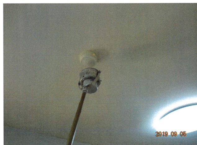
写真59(差動式スポット型感知器)
