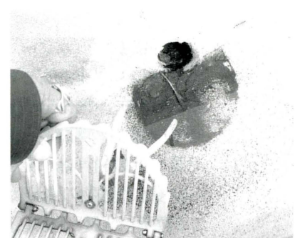
写真6 アスファルト防水増し張りによる改修ドレン部分
