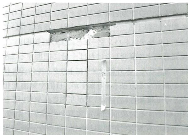
写真2 タイルの張替え補修
