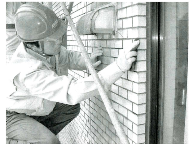
写真5 タイルの薬品クリーニング
