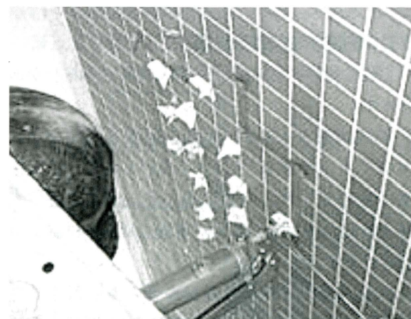
写真3 アンカーピンニングエポキシ樹脂注入による浮き補修
