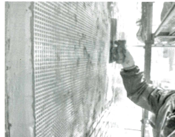
写真4 ピンネット工法による補強下地の構築作業
