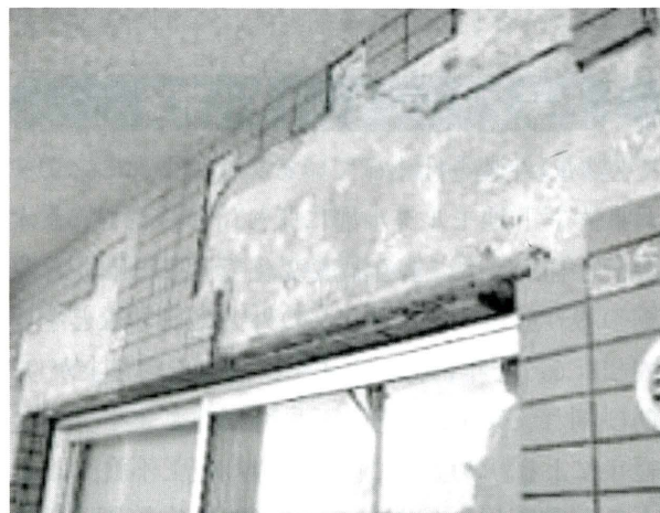
写真1 広範囲に浮きが生じたタイルを撤去した跡
