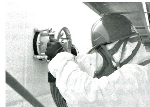
写真2 集塵機能付き高圧水洗機による既存塗膜除去
