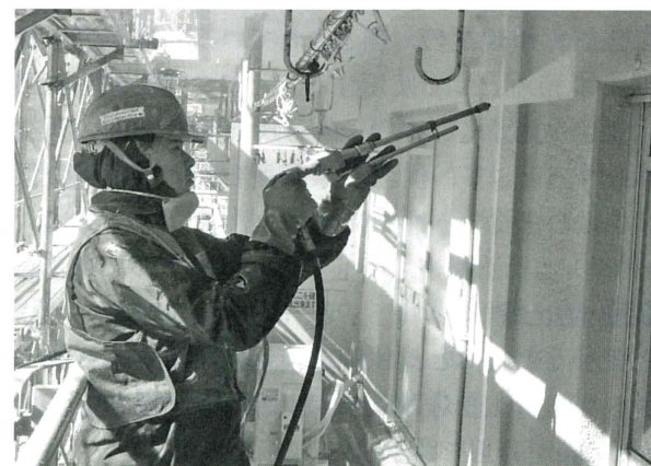
写真1 高圧水洗浄により事前処理
