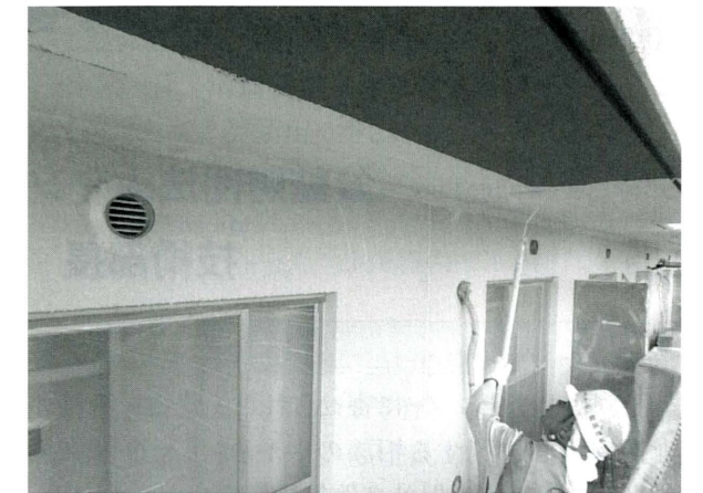
写真5 ベランダ廻りにおける塗装作業の様子
