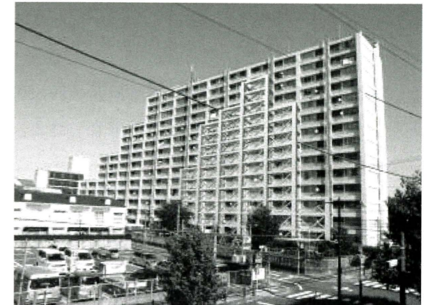
写真1 補強計画案1 ブレース付きアウトフレーム
