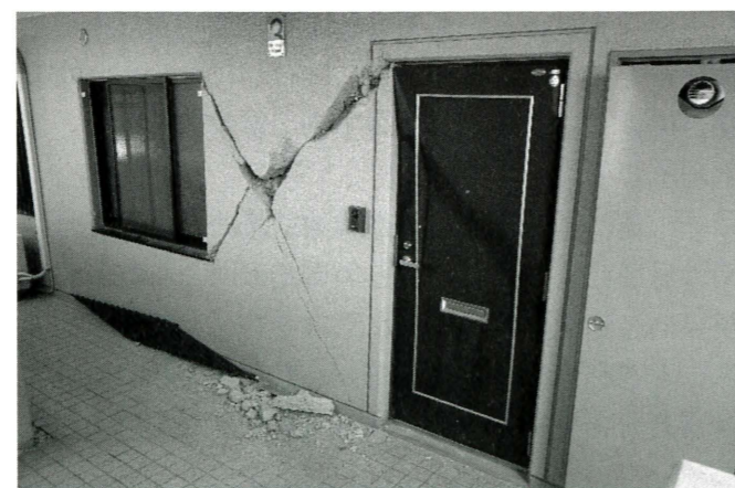
共用廊下等の非構造壁に生じたひび割れ
