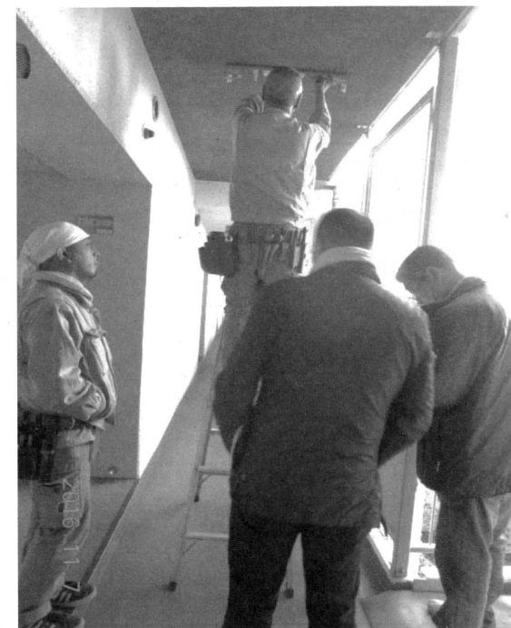
【共用部分の電気配線の不具合が見つかり、原因特定のための調査をしているところ】
