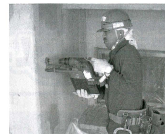
写真2 アンカーピン打設
