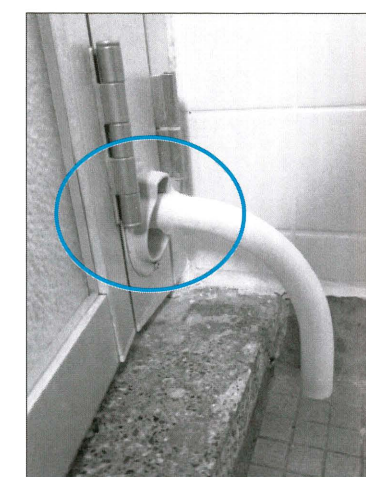
写真1 浴室ドアの建具スリーブ
