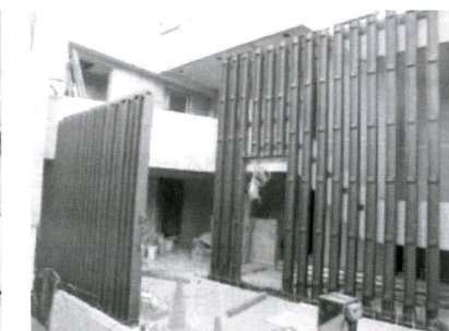
写真8 施工中：オートロックシステムエントランス設置のためにフレームを設置
