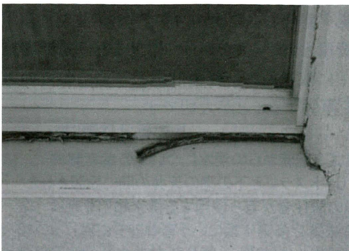
写真6 窓廻りのシーリング防水の劣化例 雨水が吹き付けて漏水する懸念あり
