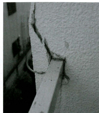
写真8 金属手摺付け根の腐食とコンクリートの盛り上がりの例
