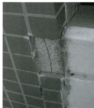
写真7 ひび割れ上部のタイル剥落の例
