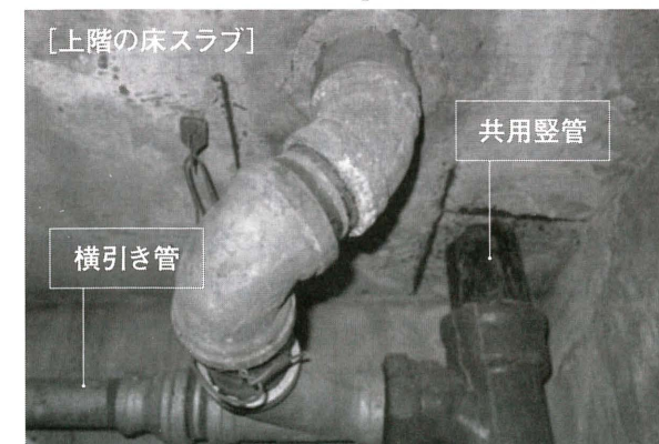
写真3 スラブ下排水管の腐食例
