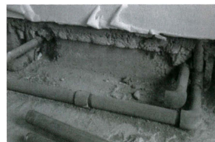
写真1 専有部分の床下の給水管の劣化例
