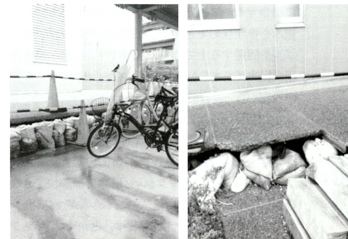
左：東日本大震災における液状化被害 右：地盤沈下し建物と駐輪場との間に大きな高低差ができた様子 画像：国崎信江撮影
