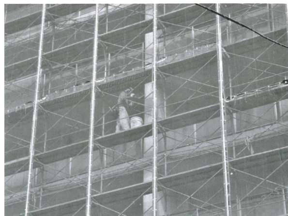
写真1 黒色メッシュシートの例（外部から作業員が確認できる）
