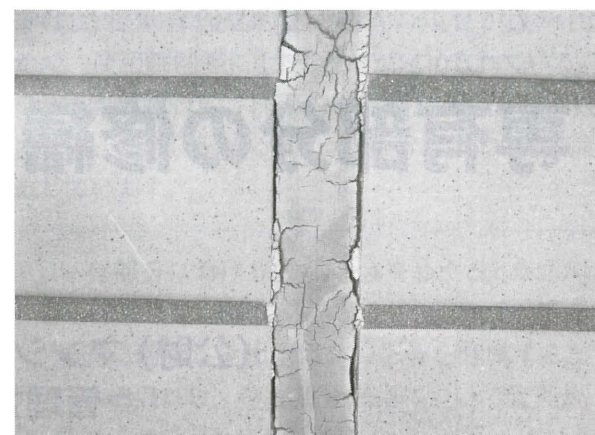
写真4 劣化したシーリング材の例
