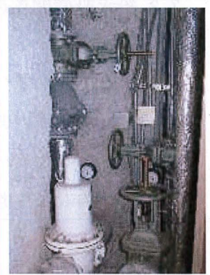
写真-9 減圧弁の状況
