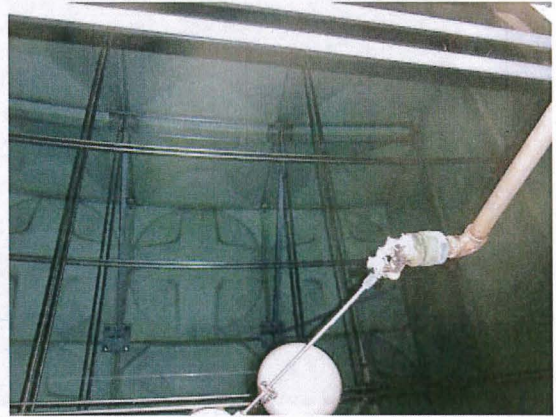
写真No. P-34 F303-152 受水槽内部
