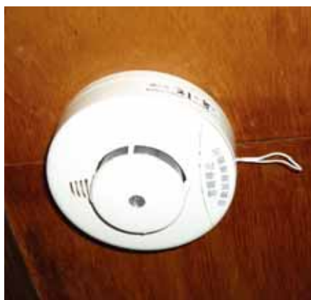
住宅用火災警報器設置
