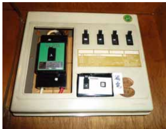
ブレーカーの位置の確認 漏電ブレーカーなどの設置
